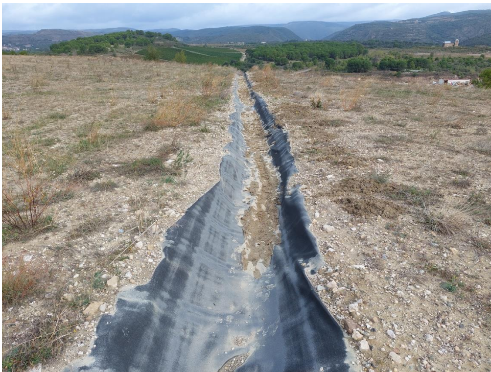
Photo 7 : Nettoyage fossé de surface membrané (C02)
