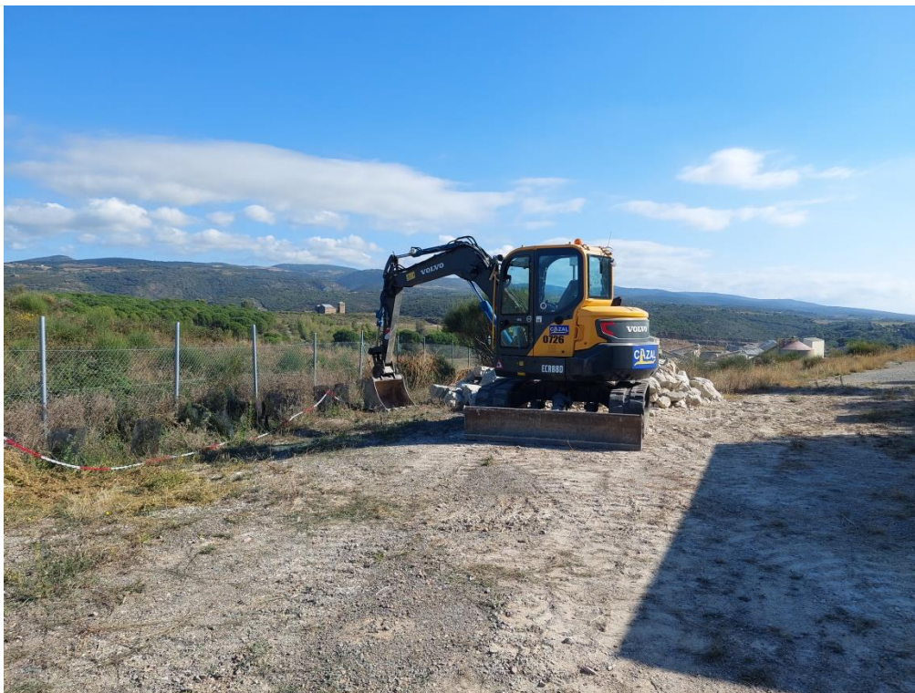
Photo 5 : Mini pelle pour chantier
