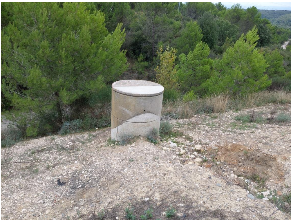
Photo 8 : Couverture béton remis en place sur le puits flanc sud
