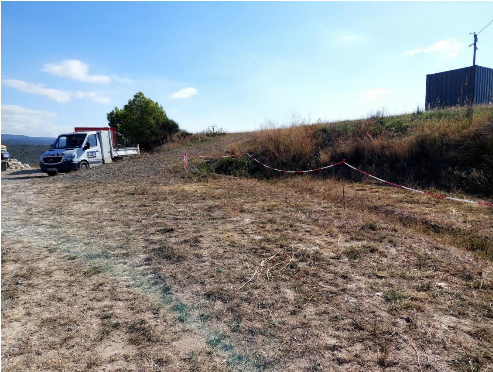
Photo 3 : Véhicule dédié au chantier et parking au premier plan
