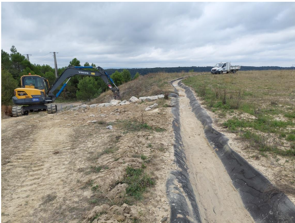
Photo 7 : Nettoyage fossé C03
