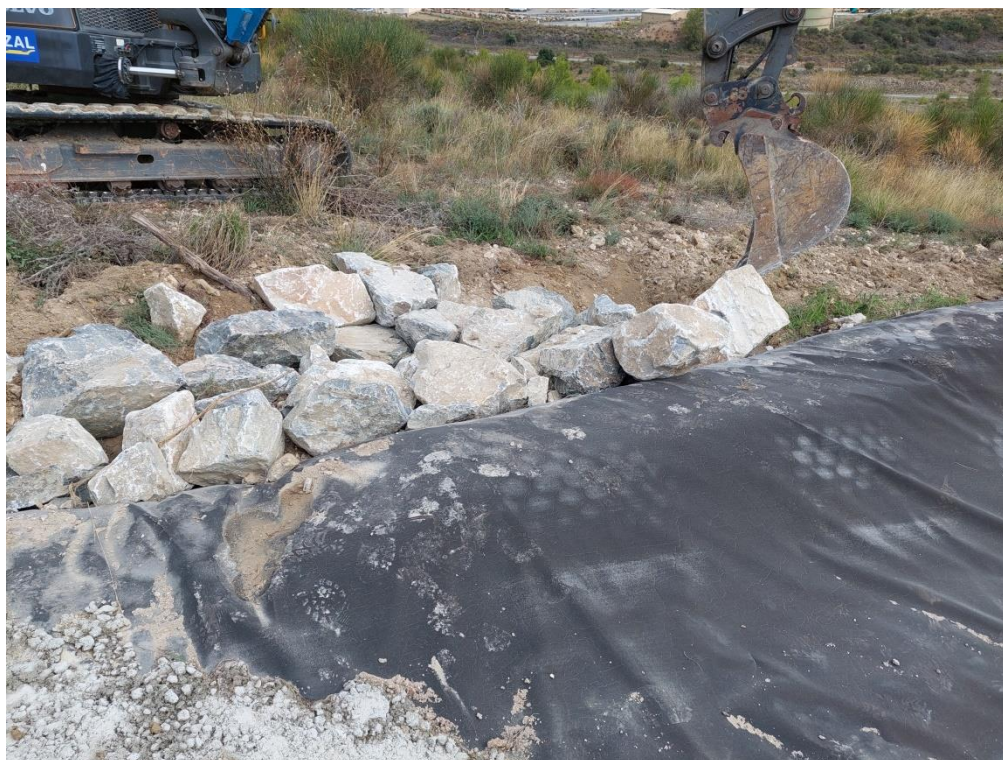
Photo 8 : Mise en place d'engrochement le long de la descente d'eau (A02)
