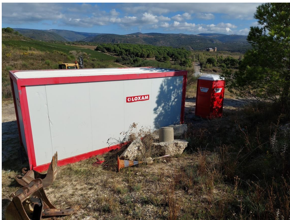
Photo 1 : Base vie et sanitaire
